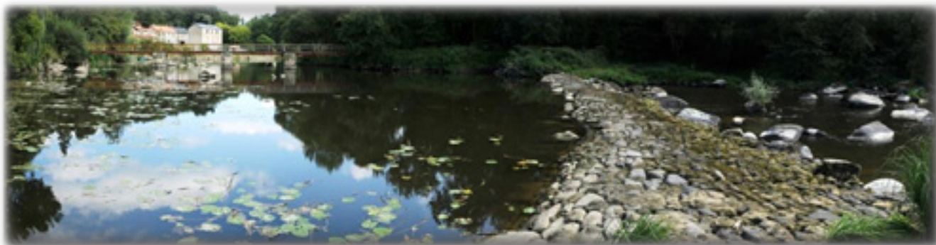
Photo 3 : Exemple d'un ancien ouvrage à Chevalier, commune de Boussay, sur la Sèvre Nantaise (P. Trécul)
